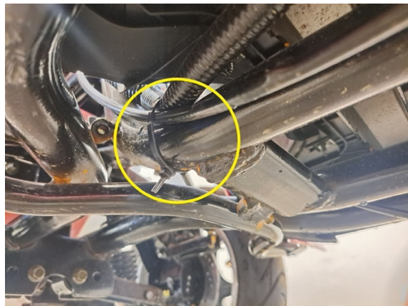
Katko johtosarjaa kannattelevat nippusiteet. (sivuleikkurit).
